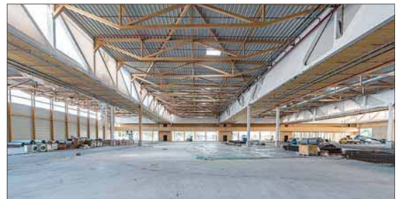
Blick in die Halle mit nur einer Zwischenstütze je Hauptträger, so dass diese als Zweifeldträger fungieren. Bu-FSH ermöglicht es, die Feldweiten von 40 m bzw. 42 m mit filigranen Träger-Abmessungen zu überbrücken. Foto: SWG Produktion
