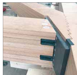
Hauptfachwerkbinder: Anschluss von Diagonalen und Pfosten über ein Koppelungsstück mit „verlängertem“ Treppenversatz an den Untergrund Foto: Susanne Jacob-Freitag
