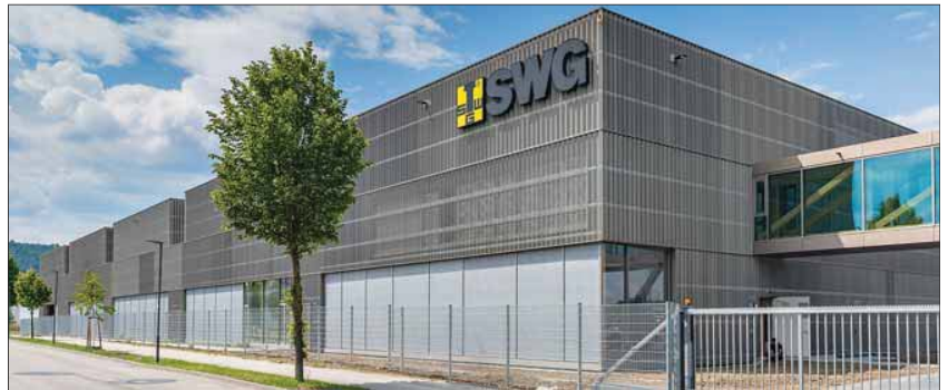
Die neue Halle der SWG ist 114 m breit und fast 97 m lang. Markant ist die Dachkonstruktion mit den Versprüngen zwischen den Hallenschiffen. Eine Brücke verbindet die Produktionshalle mit einem dreigeschossigen Büro- und Ausstellungs-Pavillon. Grafik: HK Architekten
