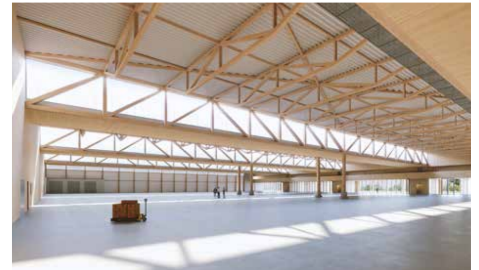
82 Meter lange Fachwerkbinder bilden das Haupttragwerk der neuen Halle..
