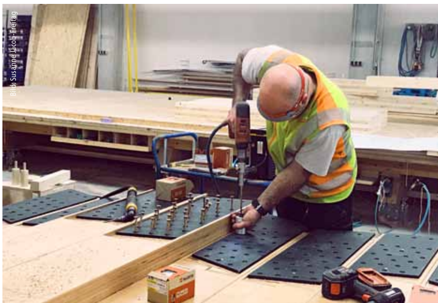
Werkseitiges Eindrehen von Schrauben mit Führungshülse: Bei Bauteilen aus Buchenfurnierschichtholz ist es wegen der hohen Materialdichte erforderlich, vorzubohren. Zum Eindrehen der Schrauben benötigt man einen Schraubbohrer mit hohem Drehmoment.
