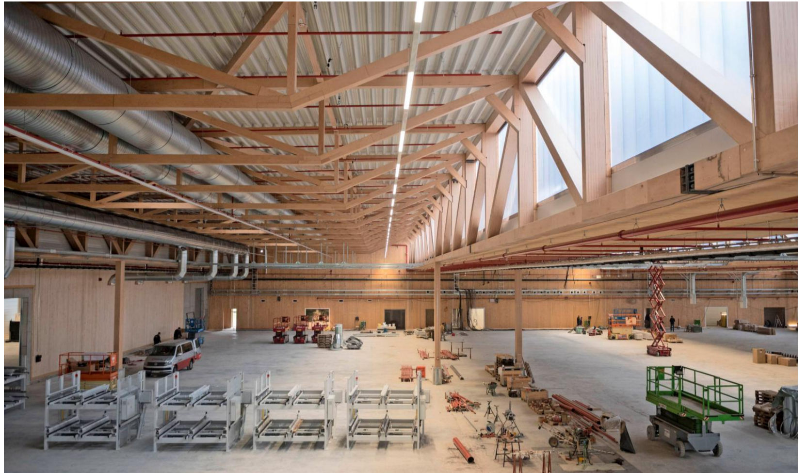
Ein imposantes Bauwerk: Das Dach der SWG-Produktionshalle im Gewerbepark Hohenlohe ist eine reine Holzkonstruktion.
