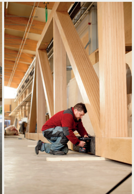
Die Montage der Hartholzelemente erfordert spezielles Werkzeug und Verbindungsmittel mit besonderer Zulassung.
